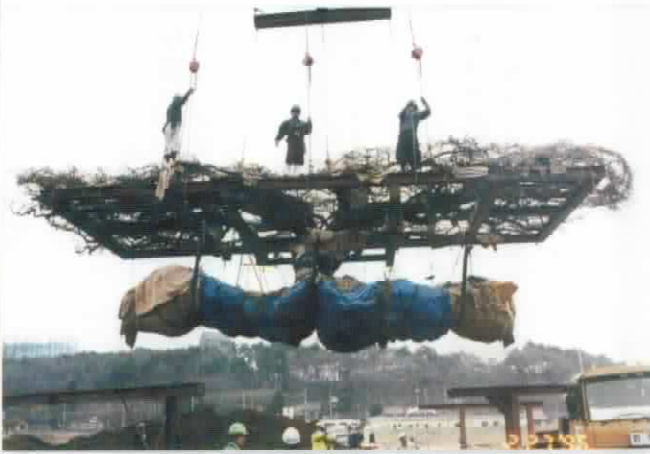
移植の際の吊り上げ状況(あしかがフラワーパーク)1996年2月27日
